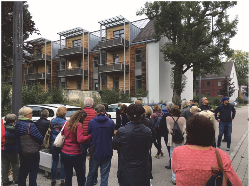
Abbildung 6. B&O Parkgelände: Blick der Teilnehmer auf ein revitalisiertes Wohngebäude mit energetischer Sanierung einer kompletten Fassade aus vorgefertigten Holz-Elementen.
