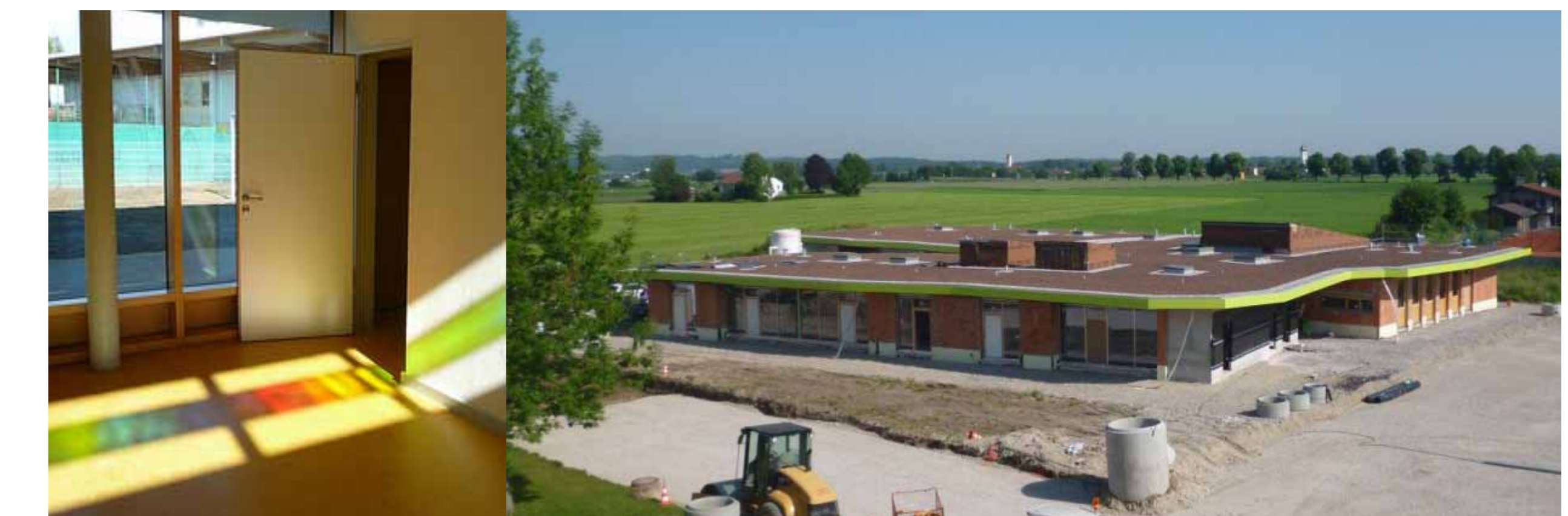
Abb. 3 und 4: Innenimpression und Außenansicht während des Baus
