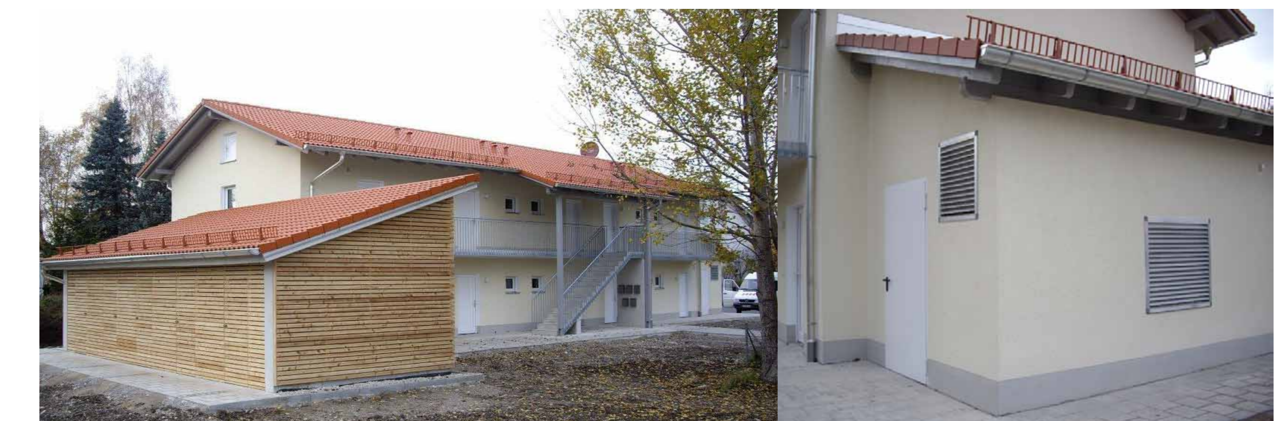
Abb. 7 und 8: Seitenansicht, Lagerräume und Technikraum des Gebäudes
