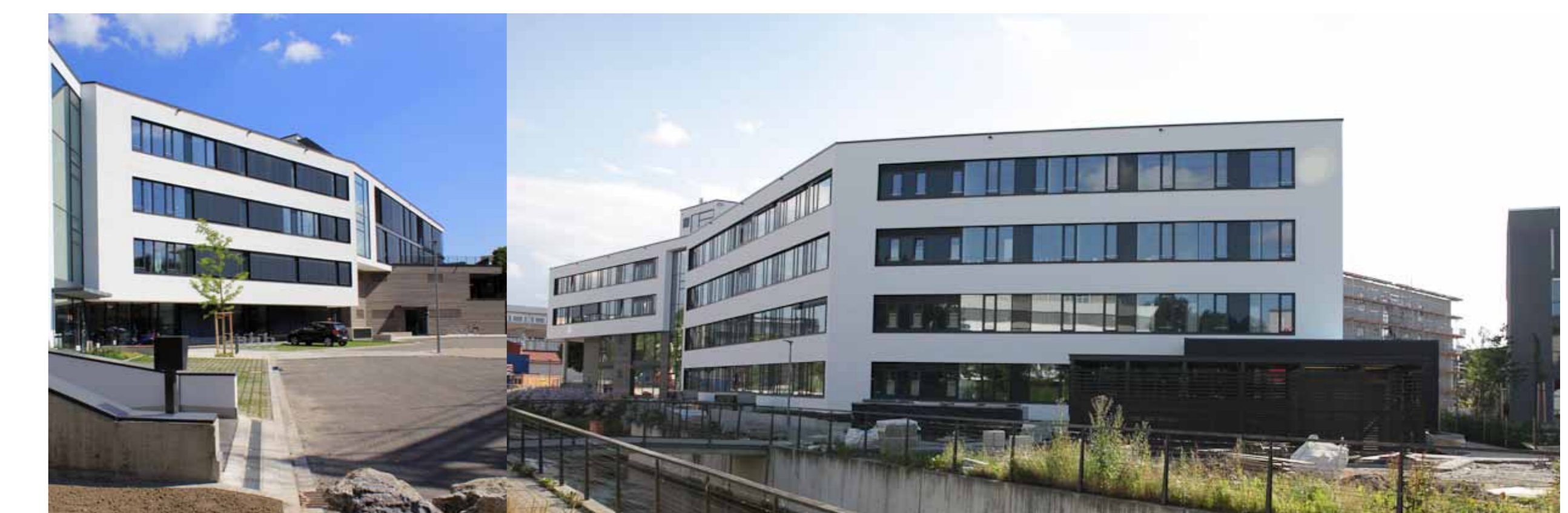
Abb. 3 und 4: Außenansichten des Bürokomplexes am Mühlbachbogen
