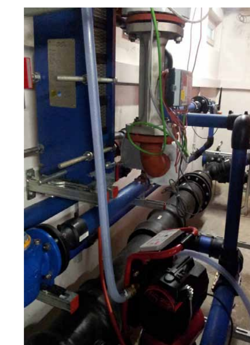
Abb. 6: Blick in den Technikraum Pumpen zur freien Kühlung der thermoaktiven Bauteile (BTA) durch den angrenzenden Mühlbach.
