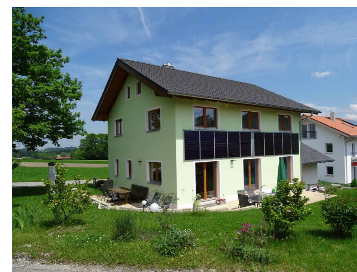
Abb. 3: Ansicht der Südwestfassade
