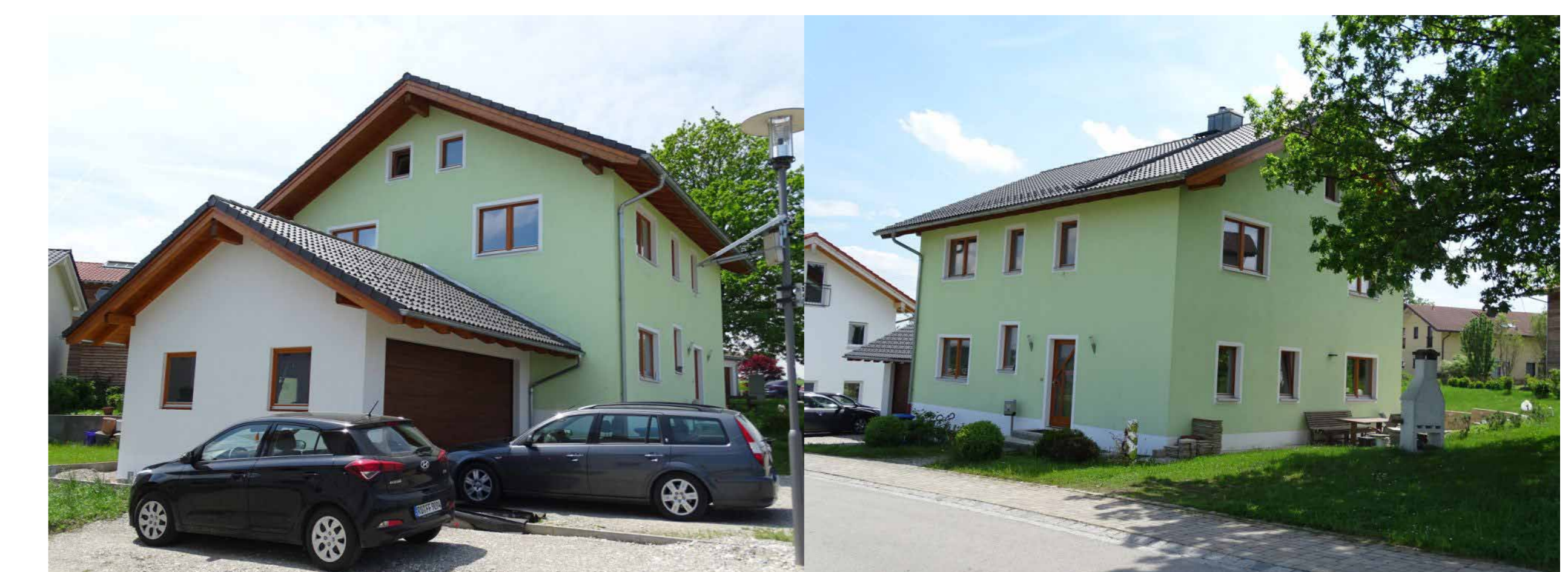
Abb. 5 und 6: Ansicht der Nordost- und Nordwestfassade mit Eingangsbereich
