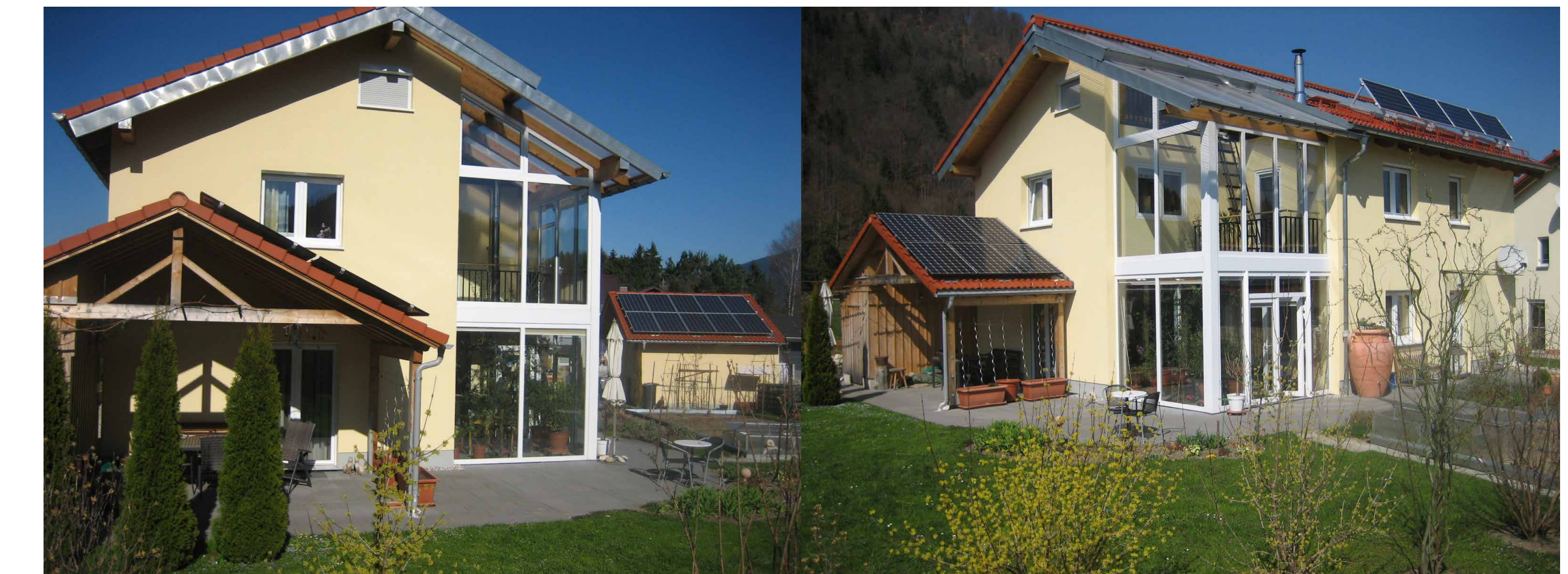
Abb. 3 und 4: Ansicht der Südwest- und Südostfassade mit Wintergarten
