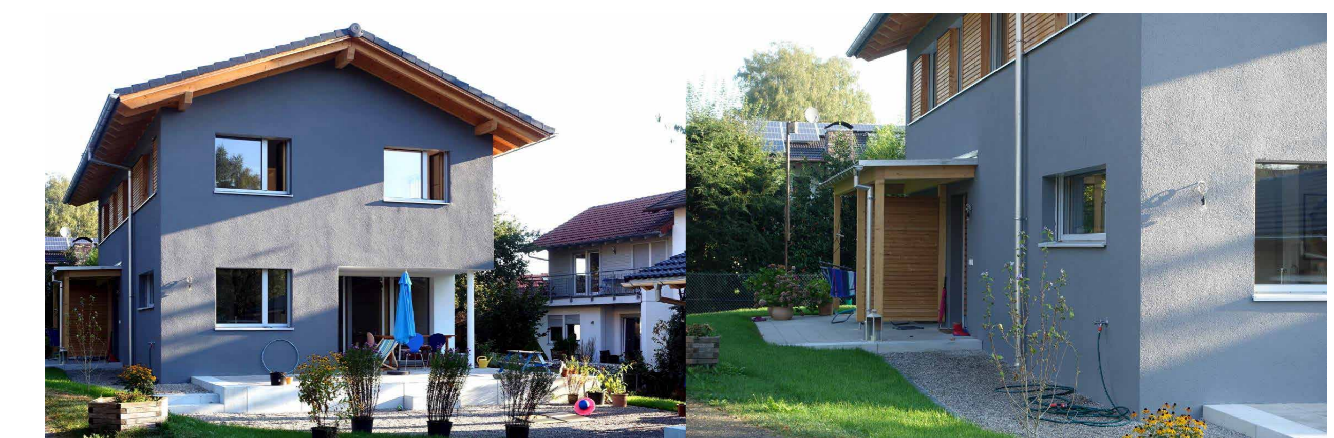
Abb. 3 und 4: Ansicht der Süd- und Westfassade mit Eingangsbereich
